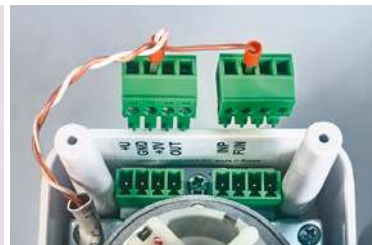
Фото 23. Подключение проводного выключателя
