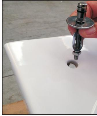
**02** Inserire fissaggio nel foro del WC.
