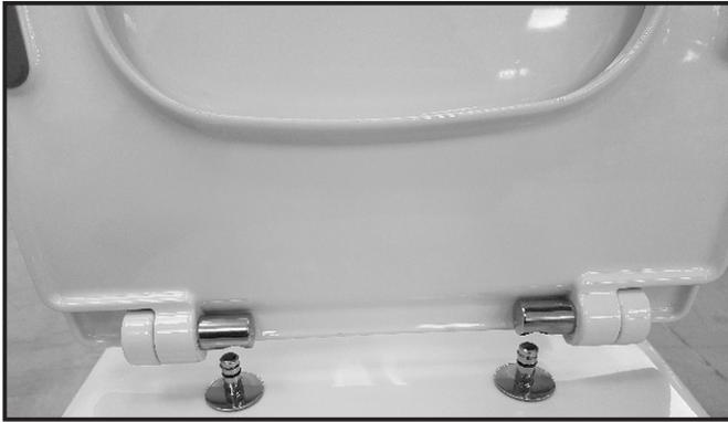
**01** Posizionare le cerniere in asse con il fissaggio.
