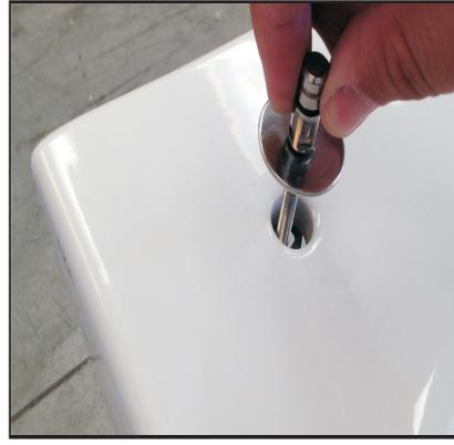
**03** Avvitare il fissaggio tenendolo sollevato ma non bloccare.
